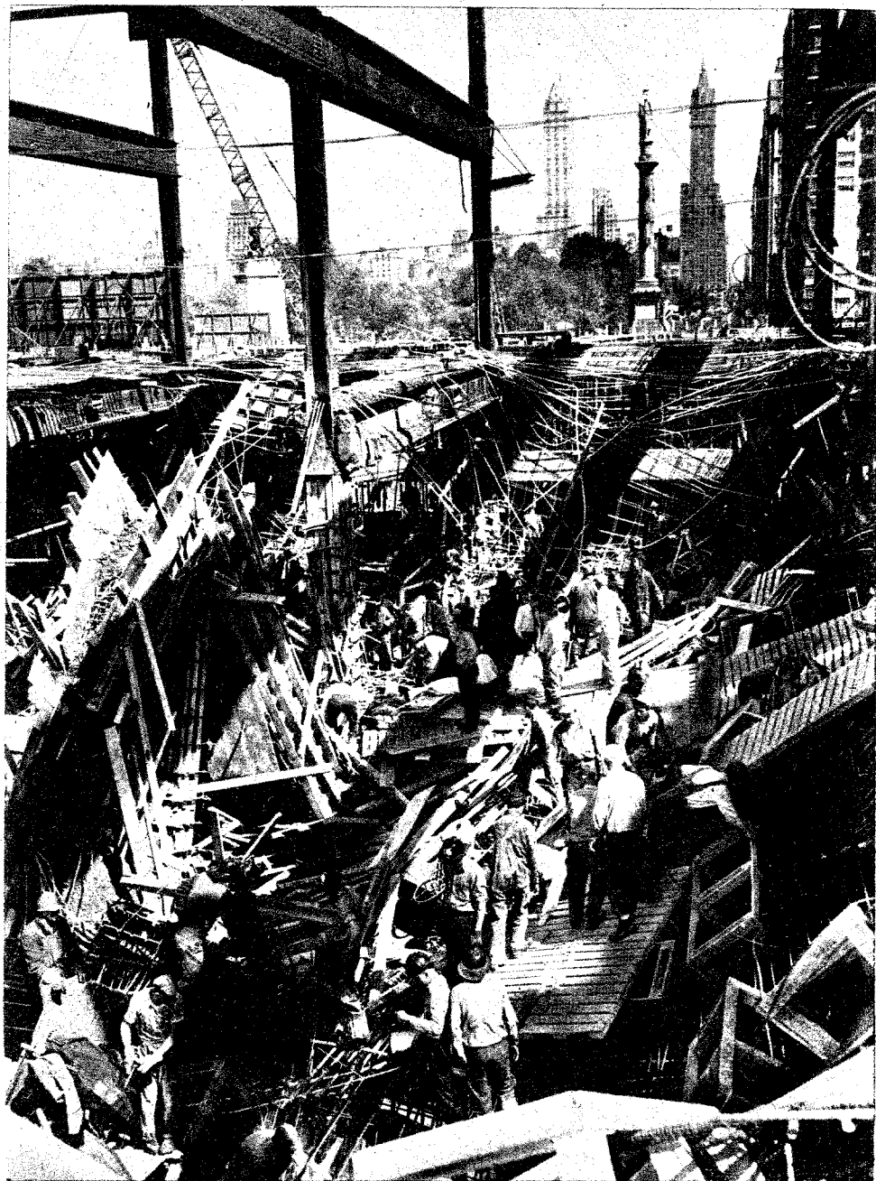
REBLANDECIMIENTO DE CIMENTOS. —Así quedó el Coliséum de Nueva York, actualmente en construcción, después del hundimiento de dos pisos. Veinticinco heridos fué el balance del suceso atribuido a un reblandecimiento de los cimientos.—(Foto Ortiz. I. N. P.)
